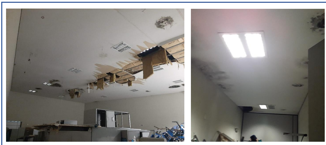
Figura 4-7 – Forro a ser removido
