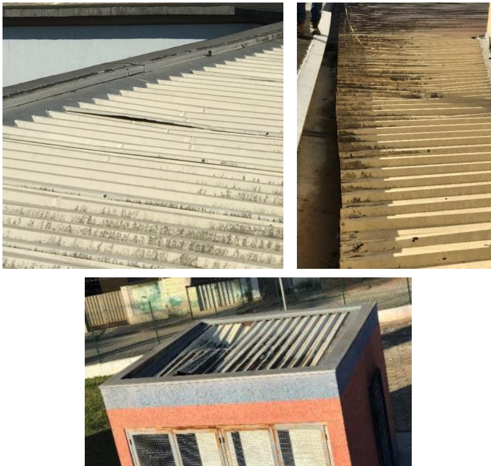
Figura 4-14 – Telhas danificadas
