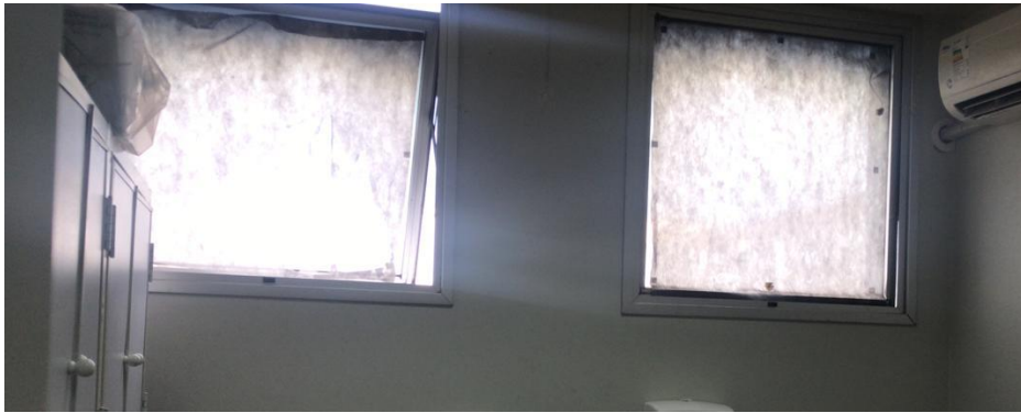
Figura 4-13 – Película jateada a ser removida
