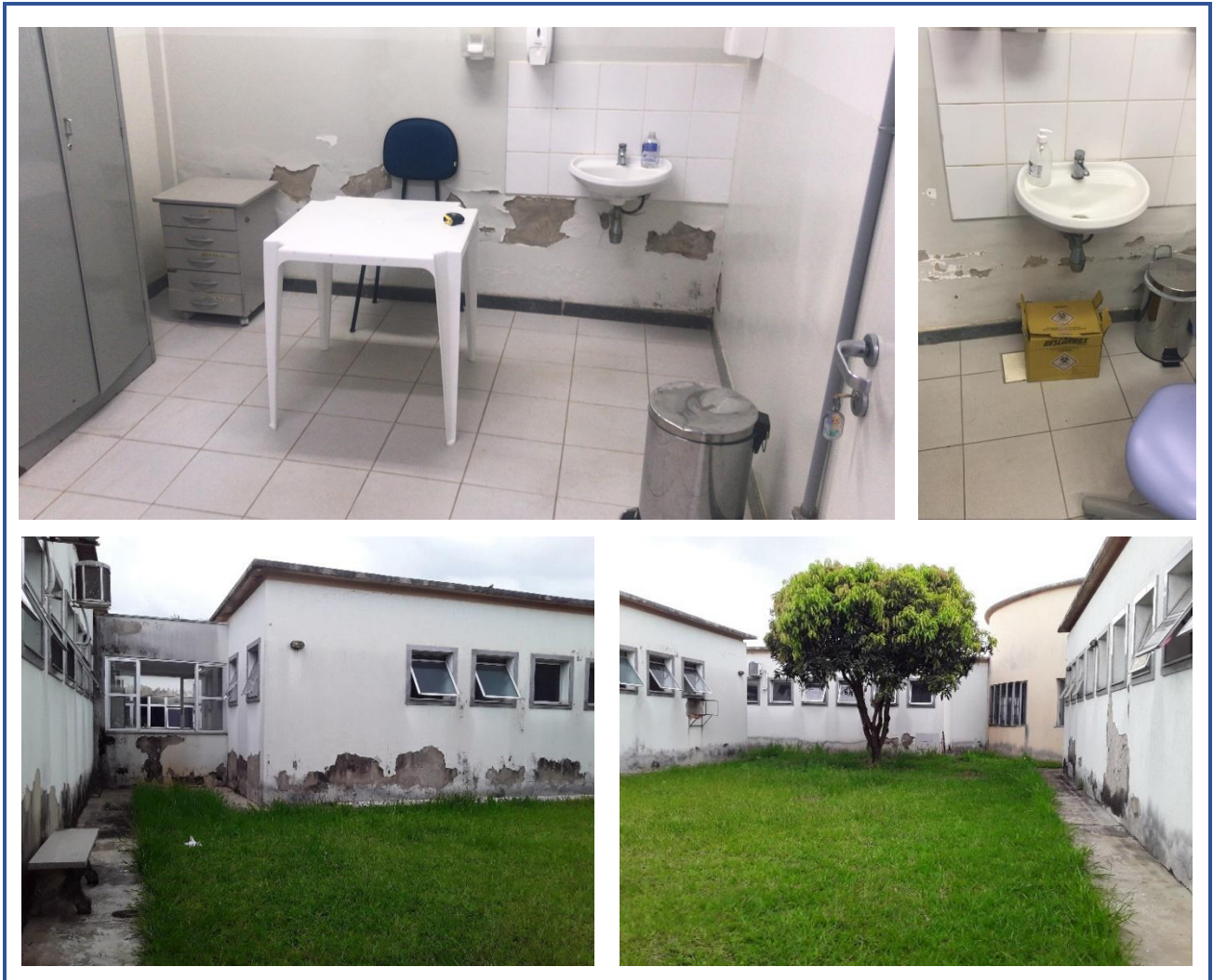
Figura 4-10 – Reboco a ser demolido
