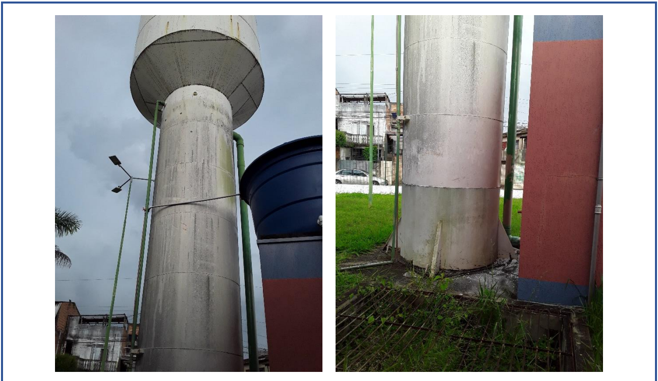
Figura 4-16 – Castelo d'água a ser substituído e a base a ser demolida
