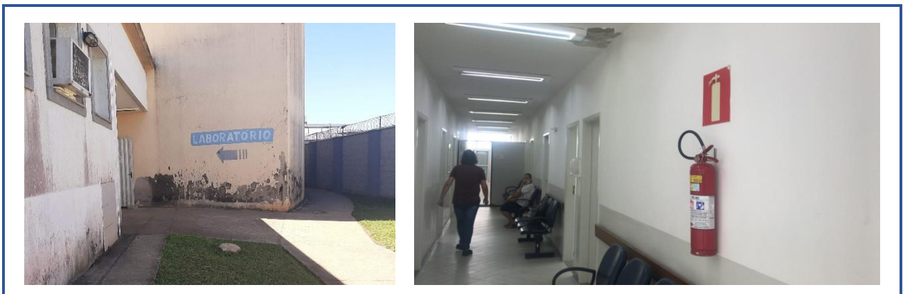
Figura 4-1 – Alvenarias a serem demolidas para a instalação de esquadrias
