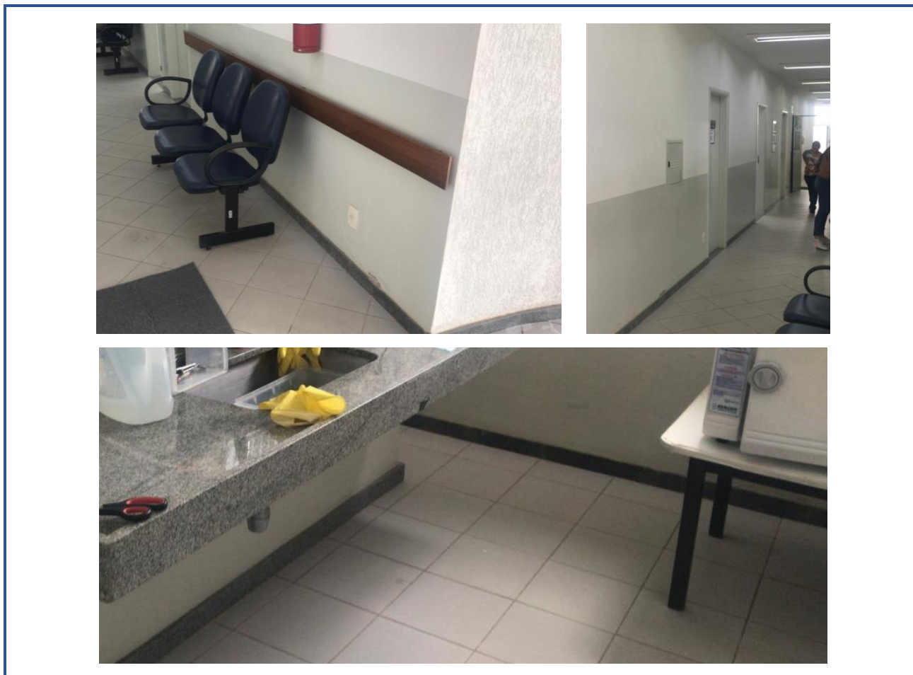
Figura 4-11 – Rodapés a serem demolidos
